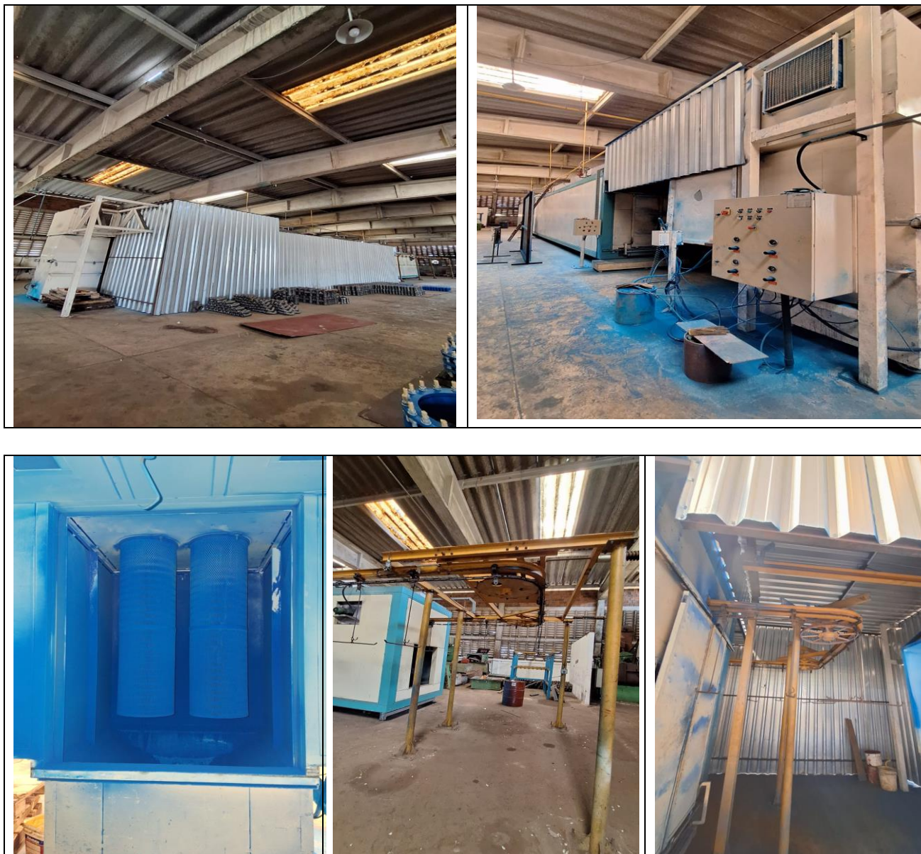
CABINE DE PINTURA
